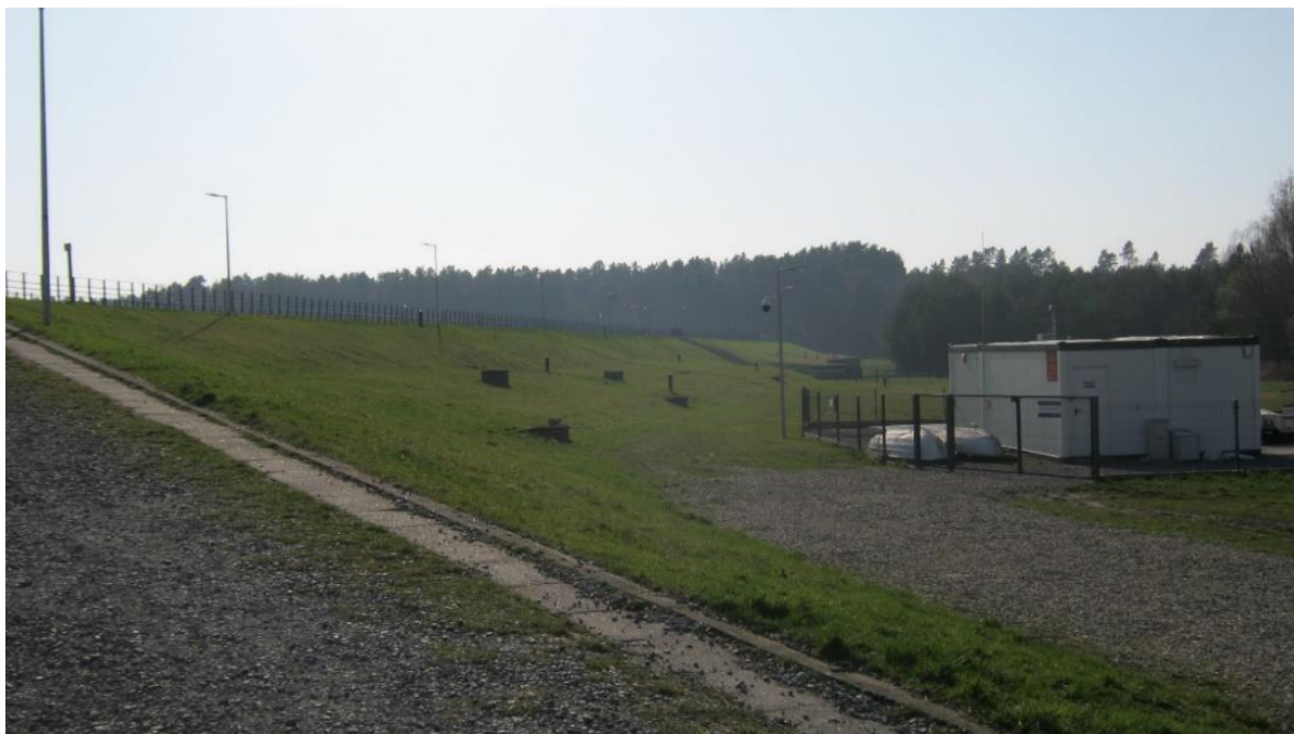
Zdjęcie 3. Elektrownia wodna przy zbiorniku retencyjnym w Wilczej Woli
