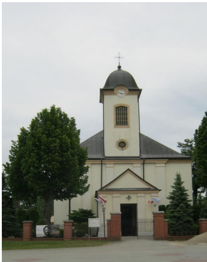
Zdjęcie 13 i 14. Zespół kościoła parafialnego pw. św. Mikołaja w Dzikowcu z dzwonnica i kapliczkami w ogrodzeniu
